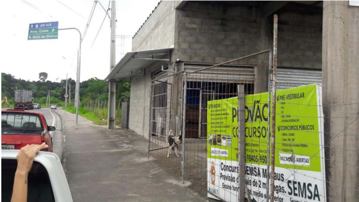
Figura 1: Edificação pertencente ao Sr. Denilson de Carvalho Vilar, inserta em Área Verde
